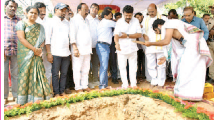
చేపల మార్కెట్ నిర్మాణ పనులకు శంకుస్థాపన చేస్తున్న మంత్రి తలసాని శ్రీనివాస్‌యాదవ్, ఎమ్మెల్యే మంచెరెడ్డి కిషన్‌రెడ్డి తదితరులు
